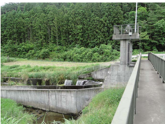
Fig. 60 全景（四ヶ村頭首工） View of the whole structure
