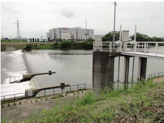
Fig. 55 全景 (稲荷山堰) View of the whole structure
