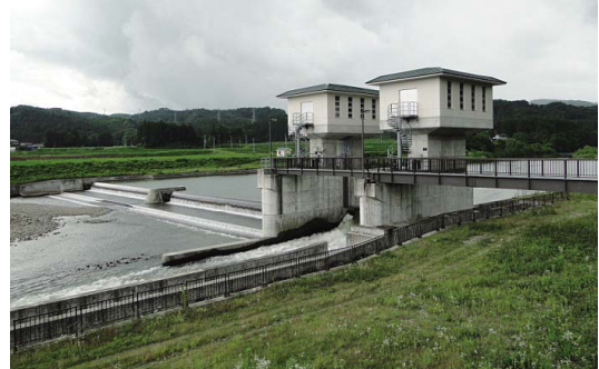
Fig. 61 全景（ニツ石頭首工） View of the whole structure
