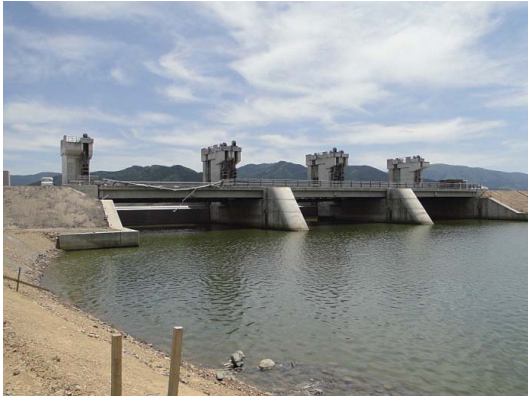
Fig. 87 全景 (月浜第1水門) View of the whole structure
