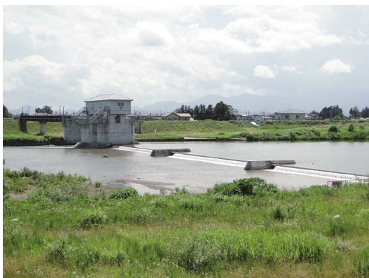
Fig. 30 全景 (清水川頭首工) View of the whole structure
