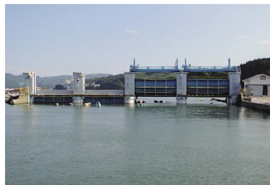
Fig. 74 全景（八幡川防潮水門） View of the whole structure
