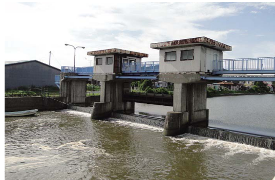
Fig. 50 全景（高城揚水機場） View of the whole structure
