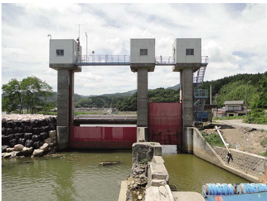
Fig. 89 全景 (月浜第2水門) View of the whole structure
