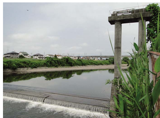
Fig. 52 全景（中野堰） View of the whole structure
