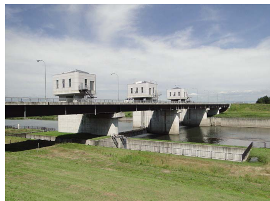
Fig. 33 全景 (桑折江頭首工) View of the whole structure
