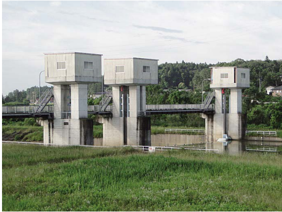
Fig. 23 全景（板倉頭首工） View of the whole structure
