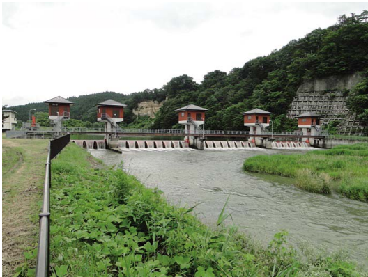
Fig. 59 全景（伊豆野頭首工） View of the whole structure
