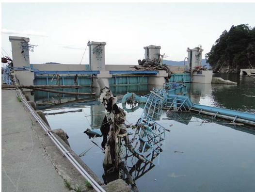
Fig. 76 全景 (水尻川防潮水門, 海中には落橋した上部管理橋) View of the whole structure
