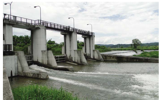
Fig. 62 全景（大堰頭首工） View of the whole structure
