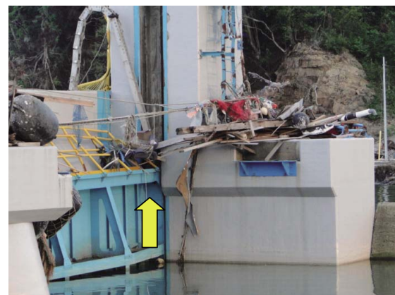
Fig. 7 ゲートの傾斜 Inclined gate
