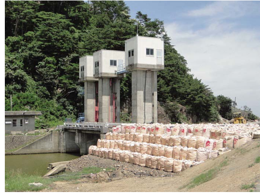
Fig. 90 右岸堤防の喪失および土嚢による復旧 Scoured and restored with sandbags at right bank
