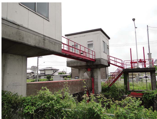
Fig. 70 全景（三ツ又水門） View of the whole structure
