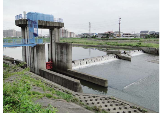
Fig. 67 全景 (薄ヶ沢頭首工) View of the whole structure
