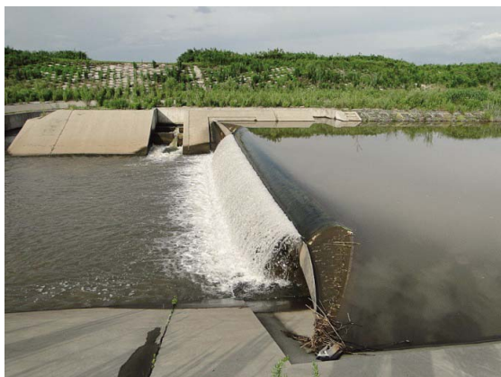
Fig. 25 全景（熊川頭首工） View of the whole structure
