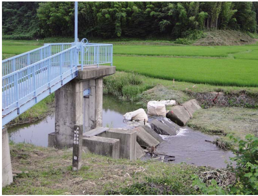
Fig. 46 全景（十字堰） View of the whole structure
