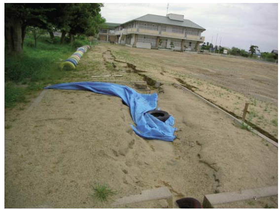
Fig. 64 校庭に発生した亀裂と噴砂 (地点番号 4) Cracks and liquefied sands on the Schoolyard (No.4)
