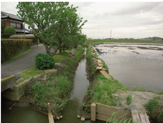
Fig. 62 掘り出された柵渠のコンクリート板 (地点番号 2) Excavated concrete plates used in concrete pile canal (No.2)
