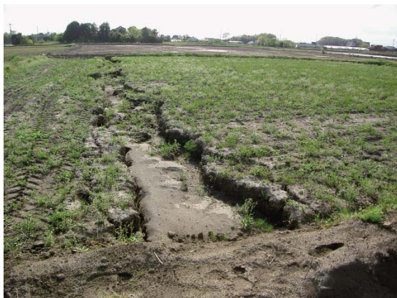
Fig. 57 水田に発生した帯状の噴砂（地点番号 2） Strip zones of liquefied sand on a paddy (No.2)
