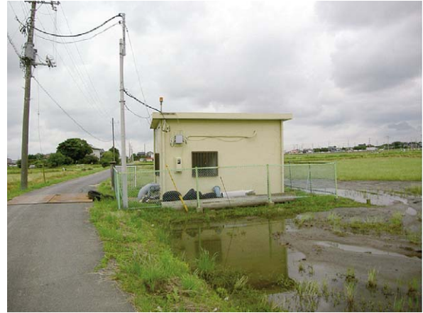
Fig.14 石納排水機場 (地点番号 5) Drainage pumping station in Kokuno (No.5)
