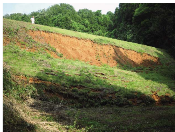
Fig. 52 能登地震の後に降雨ですべりが発生したため池（銭茂谷内ため池）
