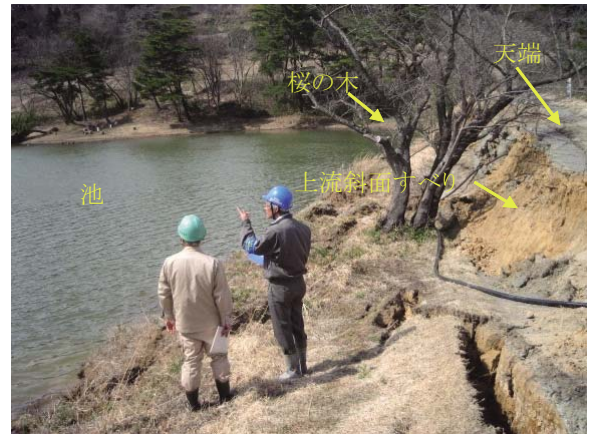
Fig. 18 蛇の鼻中ノ池上流斜面すべり (右岸側より撮影)
