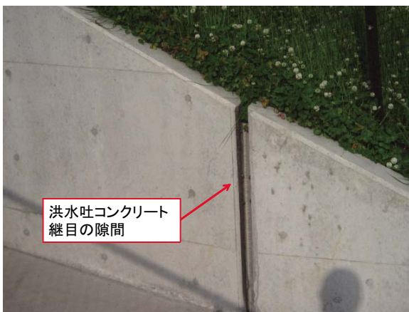
Fig. 46 八ノ口池洪水吐の目地の開き
