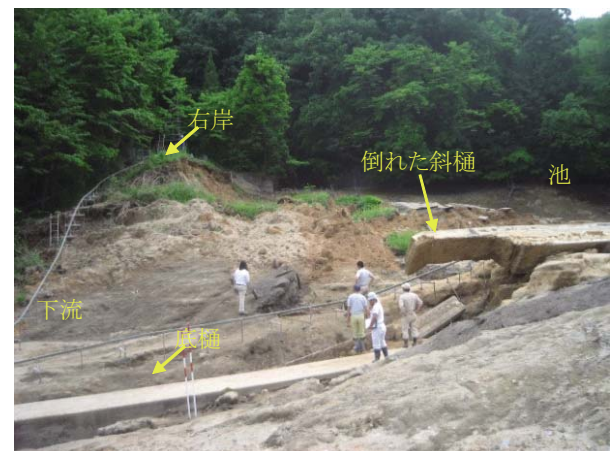
Fig. 8 決壊した中池堤体（左岸より撮影） Nakaike dam after breach (viewed from the left side)
