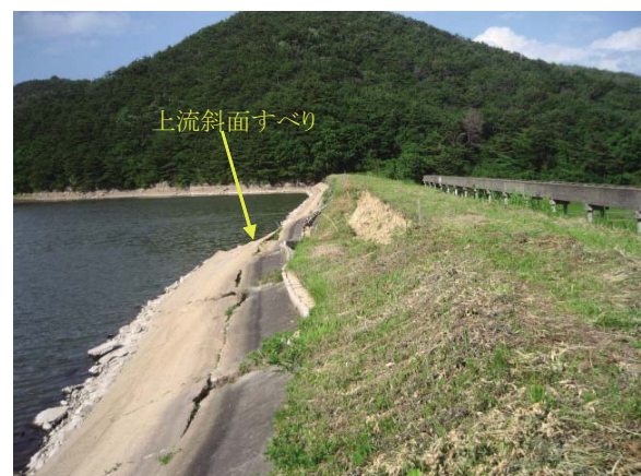
Fig. 15 岩根大池の上流斜面すべり（右岸から撮影）
