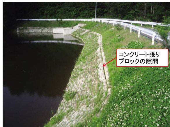
Fig. 43 家老内池上流斜面張りブロックのずれ Movement of upstream slope protection blocks of Karoushi dam
