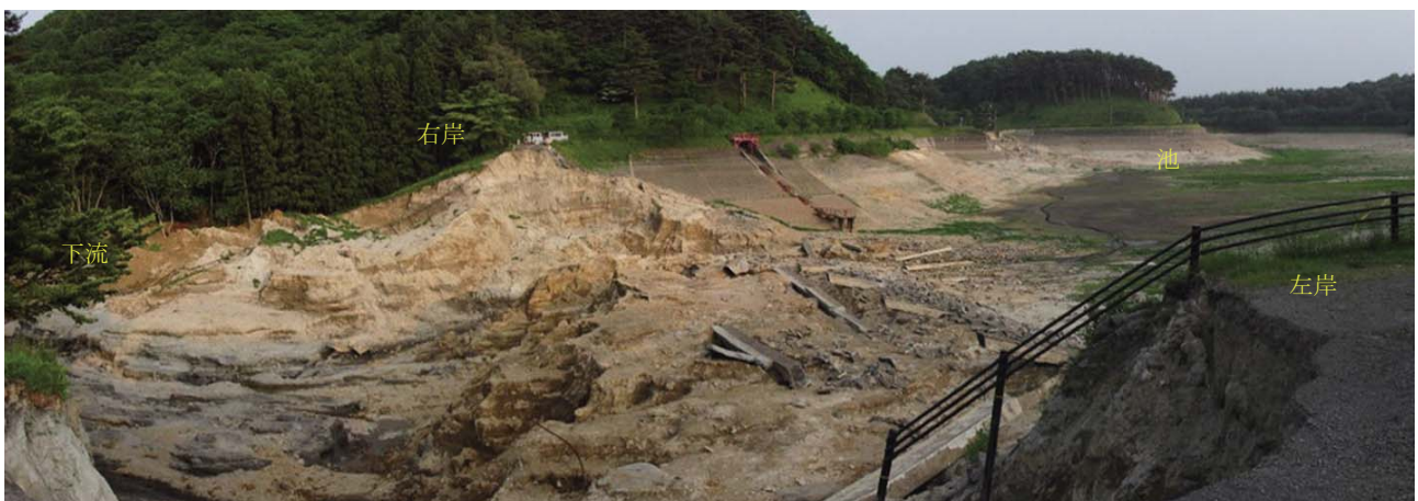
Fig. 2 決壊した藤沼貯水池 Fujinuma dam after breach
