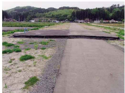
Fig. 16 大屋第 5 空気弁工 Oya No.5 air valve
