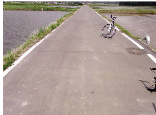
Fig. 9 下小屋第 1 空気弁工の周辺 Road around Simogoya No.1 air valve
