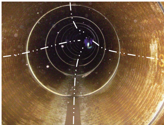
Fig. 13 曲げ配管工法 Curved pipeline
