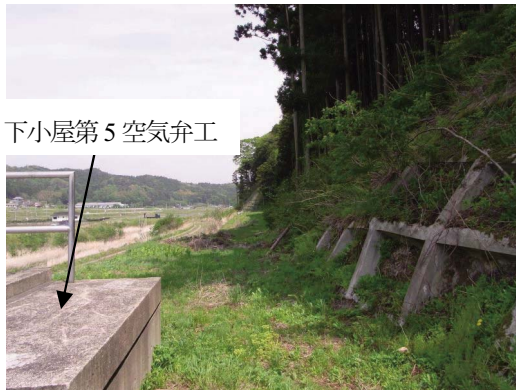
Fig. 12 下小屋第 5 空気弁工 View around Simogoya No.5 air valve
