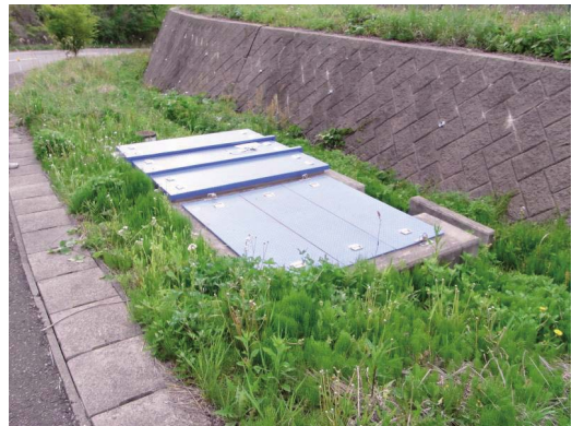
Fig. 21 第1-1幹線分土工 No.1-1 division works of main pipeline
