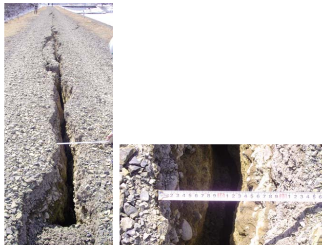
(a) 左岸側から
