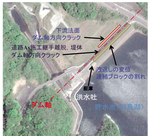
Fig. 31 羽鳥ダムの被災概要 (Google Earth 航空写真)
