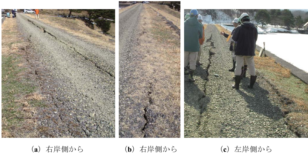
Fig. 52 堤頂のダム軸方向の開口クラック
