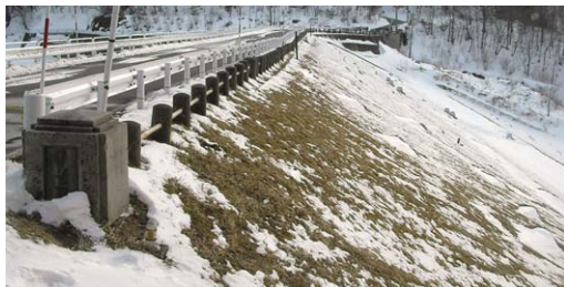
(a) 堤頂下流法肩の全体
