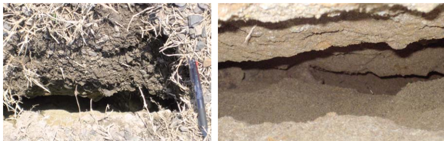
(a) 開口クラックの堤頂表面 (b) 開口クラックの内部
