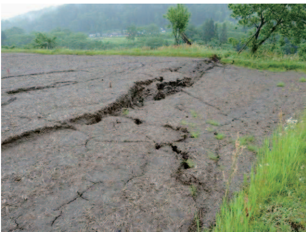
Fig. 26 田面に発生した段差を伴う亀裂 Cracked paddy field with steps
