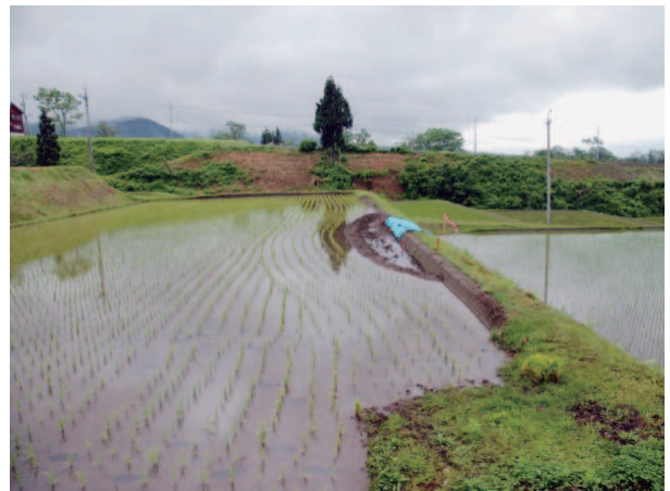
Fig. 34 畦畔法面の一部が崩落した水田 Collapse of levee slope
