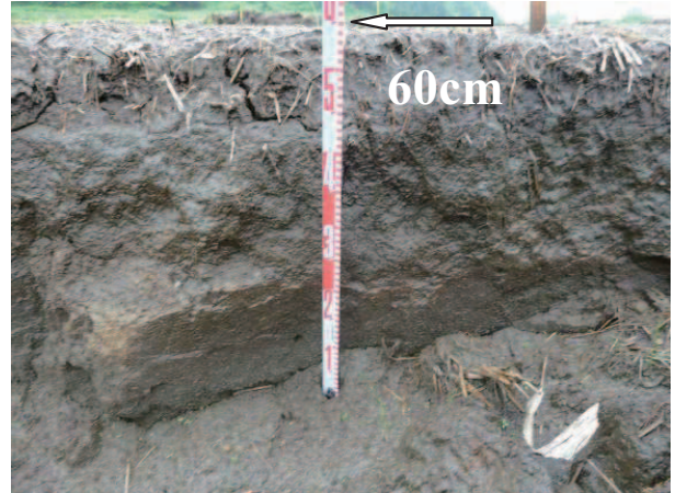
Fig. 27 田面に発生した 60cm の段差 Step reached a height of 60cm in paddy field
