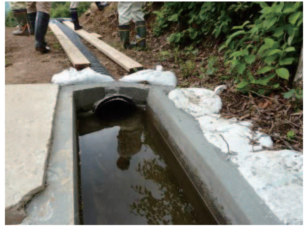
Fig. 5 既設フリューム水路とコルゲート管の接続部 Terminal area of flume and corrugated pipe
