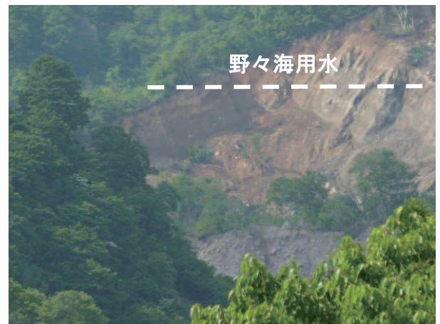
Fig. 7 山腹ごと崩落した野々海用水 Landslide with Nonomi channel
