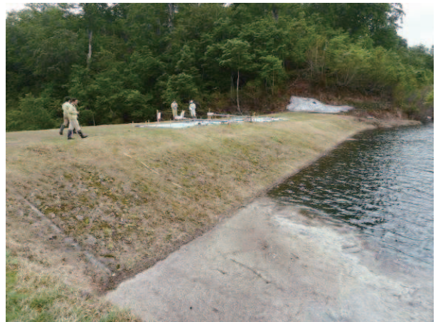
Fig. 40 堤体上流法面（左岸より） Upstream slope (left side)
