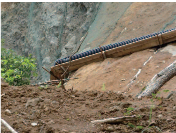
Fig. 4 応急復旧状況（水路下の林道より） Emergency restoration situation
