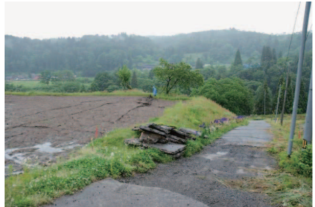
Fig. 28 段差が発生した水田と近傍農道の損傷状況 Damages to paddy field and road
