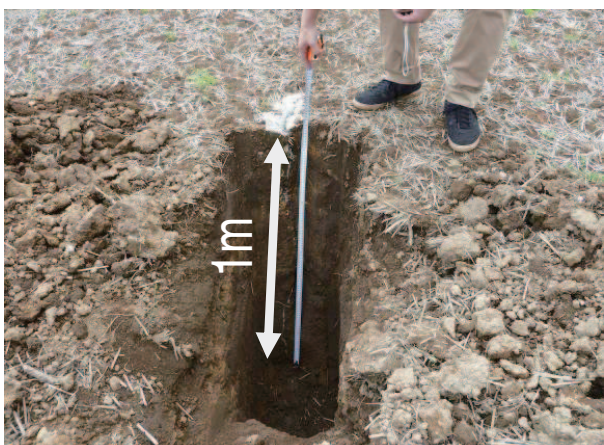
Fig. 10 深さが1mに達する亀裂 Crack reached a depth of 1m
