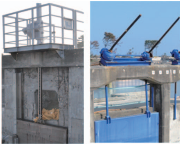
ラック式開閉装置 スピンドル式開閉装置
