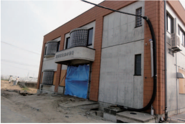
Fig. 16 コンクリート構造の排水機場（荒浜第2排水機場） Concrete structure of DPS (Arahama Dai2 DPS)
