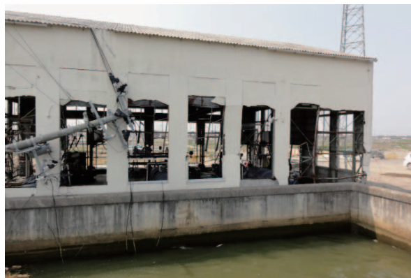
Fig. 15 パネル構造の排水機場 (荒浜排水機場) Panel structure of DPS (Arahama DPS)
