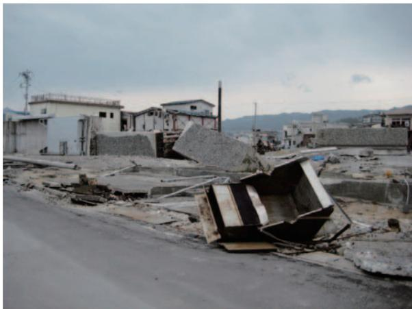
**Fig. 17 山田漁港の直立壁の破壊状況**
