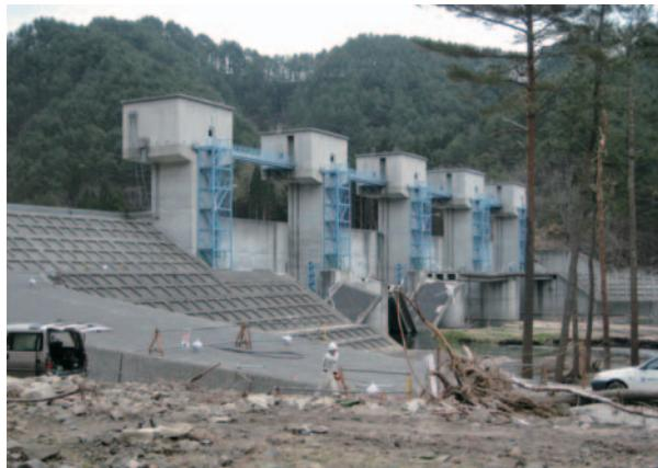
**Fig. 6** 普代川水門の状況（管理橋が崩落しているが水門全体は健全である）
