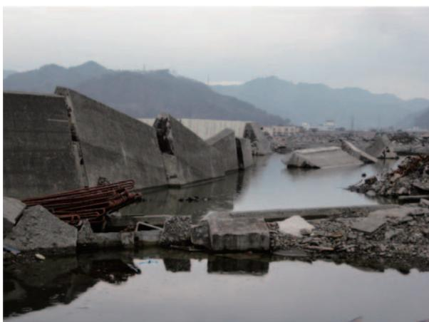
**Fig. 18 大槌漁港の堤防背後の洗掘状況**
