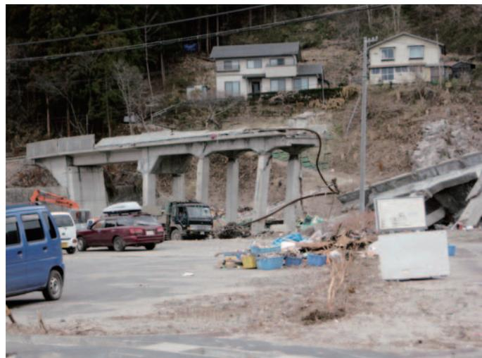
**Fig. 11** 島の越漁港海岸背後の被災状況（三陸鉄道の高架橋が崩落している背後に残った民家がある）
