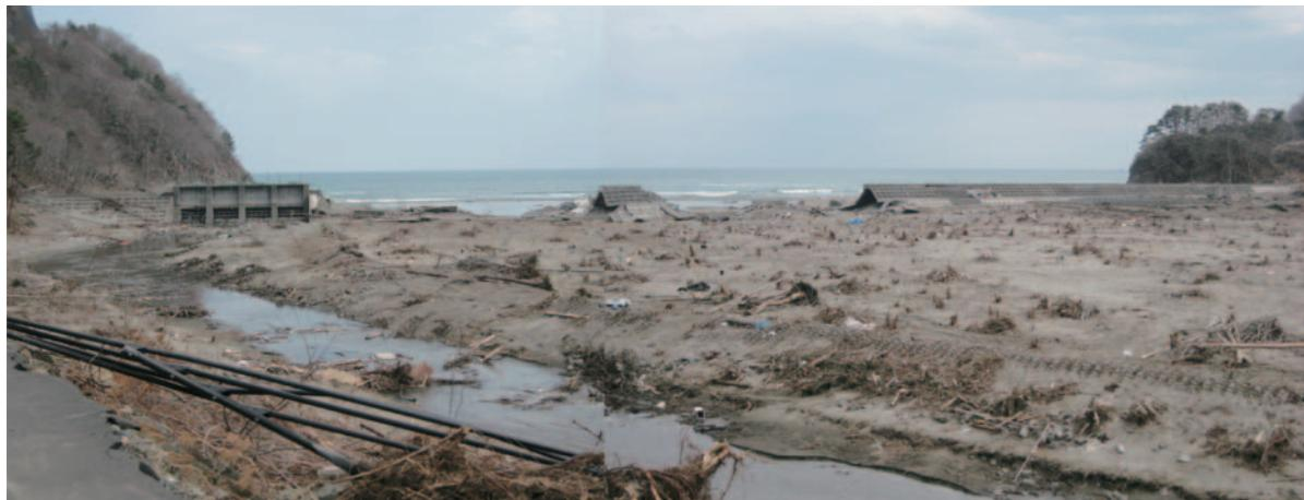
**Fig. 10** 明戸浜の海岸堤防の破堤状況
