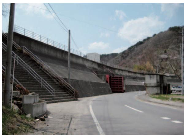
**Fig. 8** 太田名部漁港の防潮堤（津波は堤防天端から1m下まで到達した）
