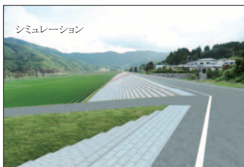
低地部のどこからでも避難できるように第2堤防を階段状にする。
