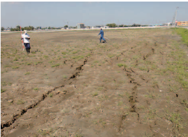
Fig. 4 調査水田内の亀裂発生状況 Crack on researched paddy fields
