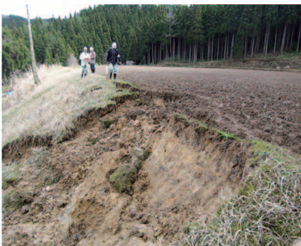
Fig. 11 法面の崩壊（能登半島地震） Collapse of levee slope (Noto Hanto Earthquake in 2007)
