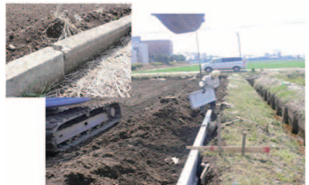
Fig. 20 コンクリート畦畔 Concrete levee
