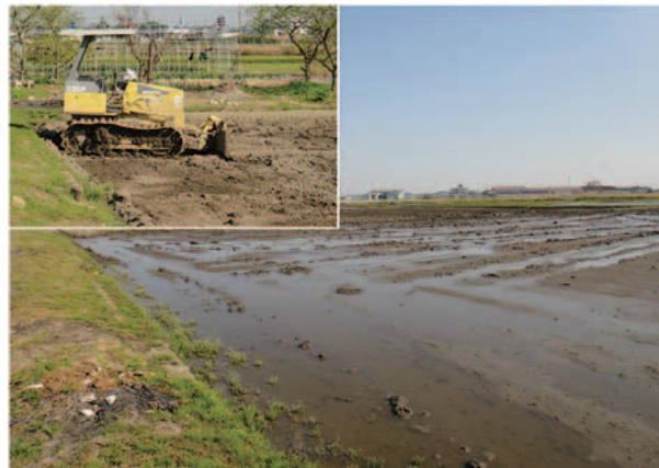
Fig. 15 ブルドーザーによる水張り均平 Ponding land leveling by bulldozer
