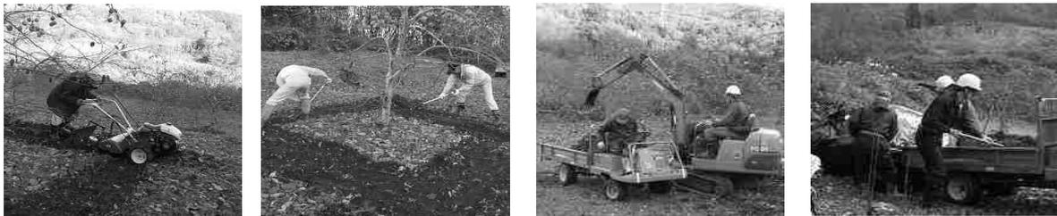
a) 剥土 b) 手直し c) 油圧ショベルですくい上げ d) フレコンバッグに収容
