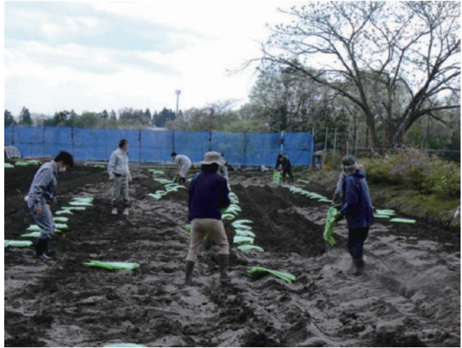
図5 手散布による転炉スラグ処理
