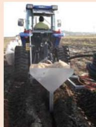
暗渠施工器による本暗渠施工状況
