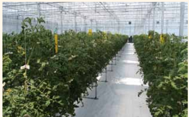
被災地域で新しい栽培システムや栽培方法の実証・展示、セミナーなどの技術交流を行うため開設した大規模施設園芸実証研究施設（宮城県山元町）
