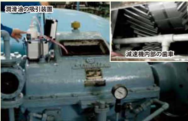
潤滑油に含まれる金属摩耗粒子を分析することで農業水利施設（ポンプ施設）の機能診断を行う技術
