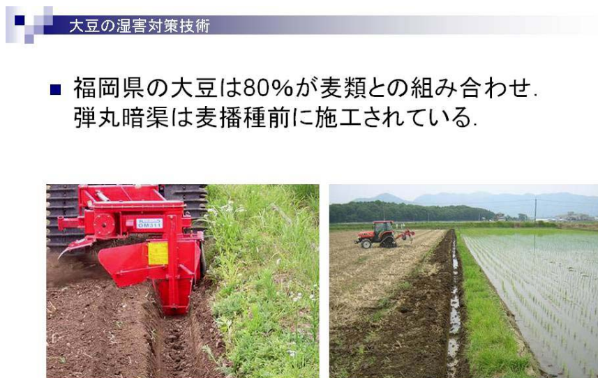
周囲溝（額縁排水）の施工
