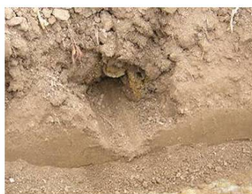
弾丸暗渠の施工後
