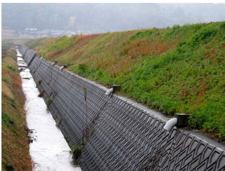
（図 2-14）本暗渠の排水口
