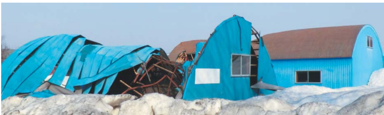
写真2 倒壊したD型ハウス（美唄市周辺）
