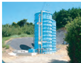
法面からの雨水を利用 した貯水(和歌山県)
