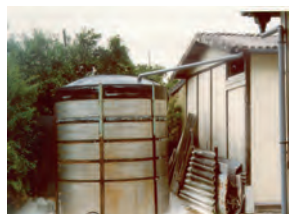
作業小屋屋根からの 雨水の貯水
