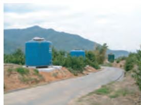
団地内貯水タンク
