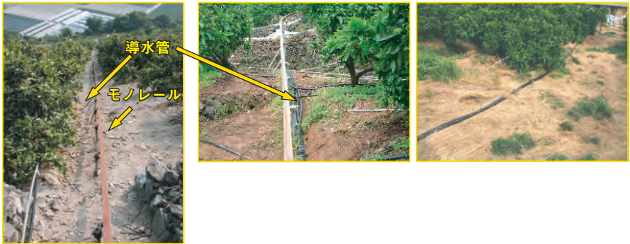
図3-3 水源から液肥関係部分までの導水 【園地内では導水管で園地管理作業に支障がないよう留意する】
