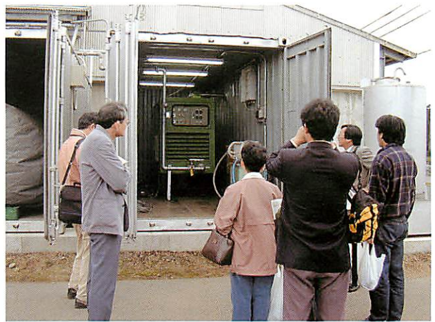
写真1 バイオマス発電設備の説明
