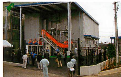
実証プラント
