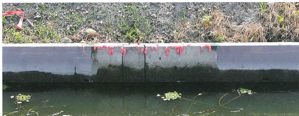
写真3 忌避剤を塗布した水路岸壁の様子
