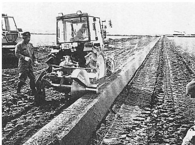
写真4 固化材使用による畦畔表層の改良
