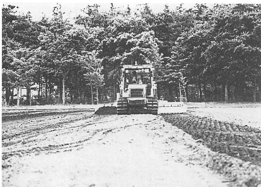
写真8 傾斜圃場造成試験（ノコギリ型）
