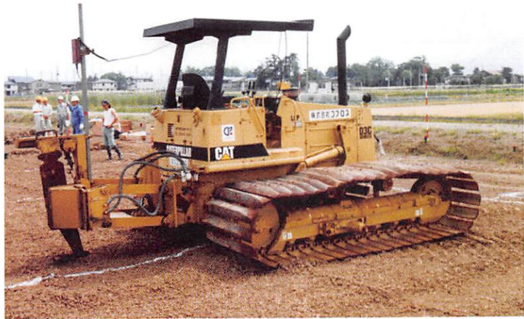
超湿地ブルドーザによる牽引作業
