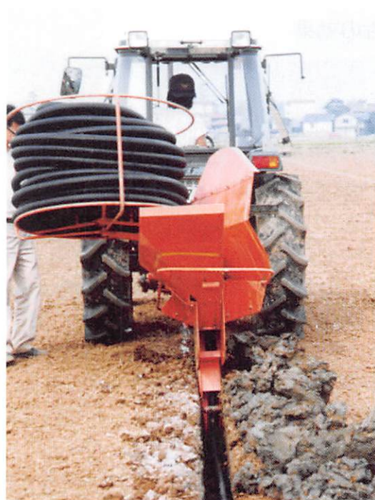
図1-1-3)-2 バケット式オーガトレンチャによる浅層暗きよ施工作业
