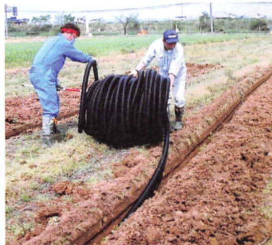
コルゲートパイプ埋設
