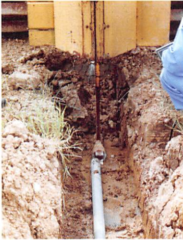
施工開始部分のチゼルとの接続
