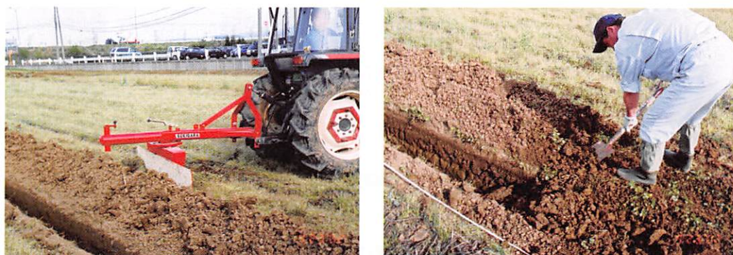
図1-1-3)-7 浅層暗きょ埋め戻し作業（左：リヤグレーダー、右：人力）
