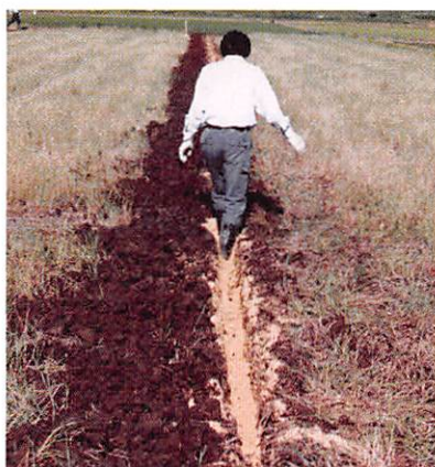
図2-5-2)-3 浅層暗きょ施行時の籾殻投入
