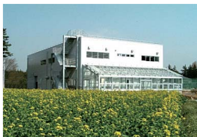
バイオマス資源エネルギー 産学官共同開発研究施設
