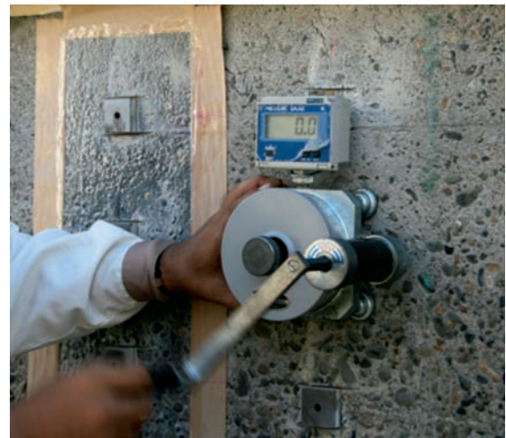
Fig.15 建研式付着試験装置による付着強度測定状況 Measurement of bond strength by the uniaxial tensile apparatus
