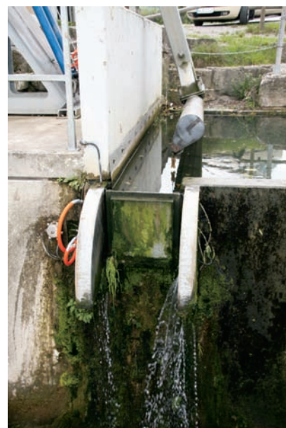
Fig.10 ゲートタイプの除塵機 Gate-type trash removal screen
