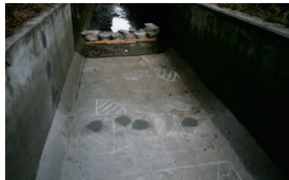
Fig.9 補修材料に発生した浮き (斜線箇所が打音によって確認された浮きの範囲) Peeling of the surface of repair material (The oblique line shows the peeling area estimated by hammering test)
