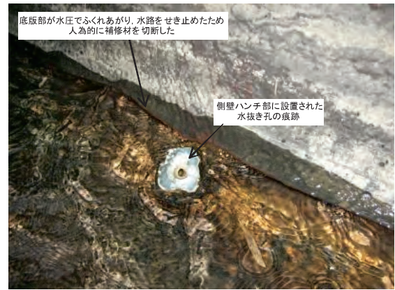
Fig.11 表面被覆材がはく離した箇所に見られた湧水処理の痕跡
