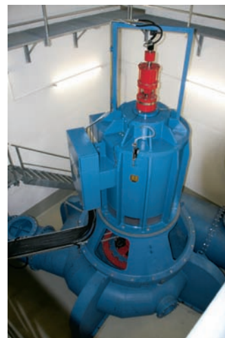
Fig.3 カプラン水車 Kaplan turbine at Main-Donau canal
