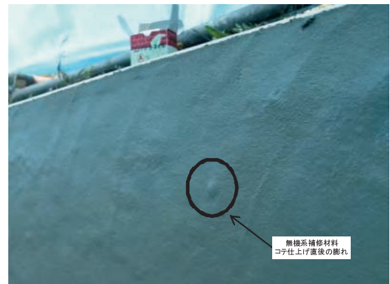
Fig.12 PCM 施工時の左官仕上げ中に発生したふくれ Peeling of the PCM in the process of plaster finishing
