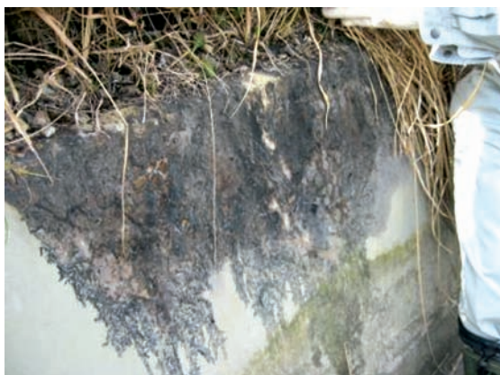
Fig.13 野焼きによる材料燃焼 Burning of the repair material
