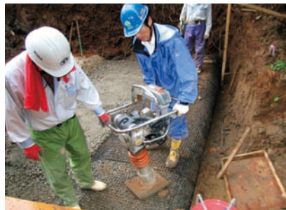
(i) 巻き込み部の上面を転圧する
