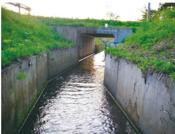
Fig.6 三面張り区間 Concrete lining zone
