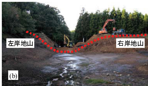
(b)谷地形上に築堤される堤体 (貯水側から下流側を見た様子)
