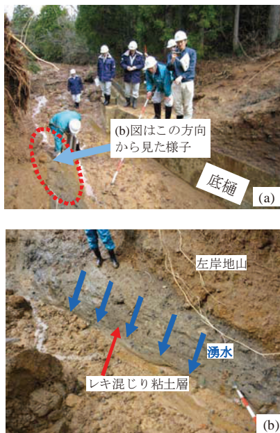
Fig.6 決壊により露出した左岸地山からの湧水： (a) 下流法先の状況； (b) 左岸地山のレキ混じり粘土層からの湧水 Seepage water from exposed ground at the left bank: (a) View of the downstream slope toe; (b) Seepage from clay containing gravel at the left bank
