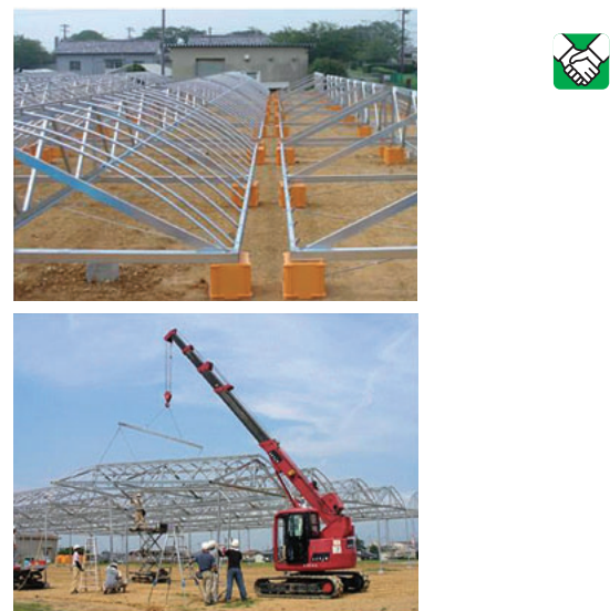
屋根ユニットの地上組立てとクレーン吊り上げ
