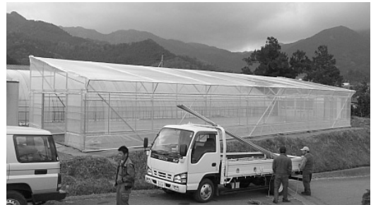
図10 JA松山市久万育苗センターに建設した片屋根型ハウス(間口5.4m, 奥行き21m)
