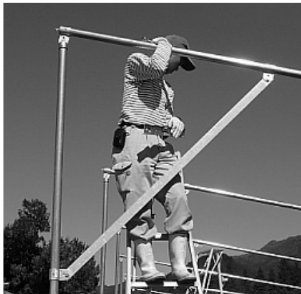
図4 等辺山形鋼による方づえ補強
