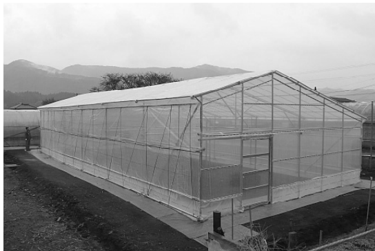
図11 愛媛県農業試験場久万試験地に建設したスリークォータ型ハウス(間口8 m×奥行き18 m)
