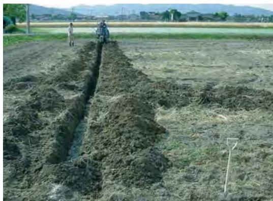
写真7 暗渠部分の掘削
