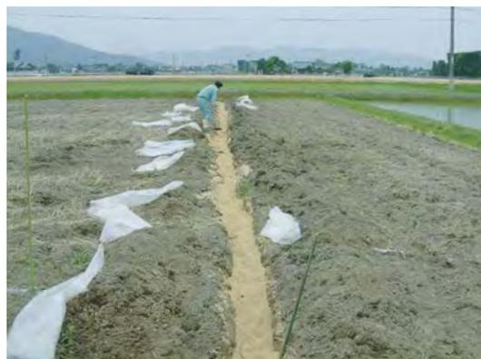
写真8 掘削部分へのモミガラ投入
