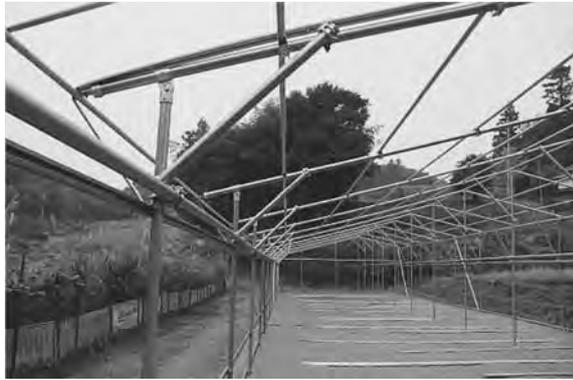
第4図 足場用鋼管と自在クランプによる方づえ補強
