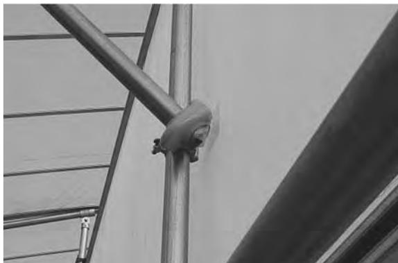
第13図 防虫網の破れを防ぐ軟質ビニル製カバー
