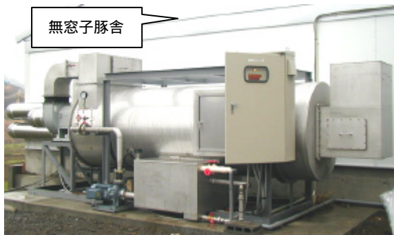
図2 無窓子豚舎に設置した細霧吸着方式の開発機
