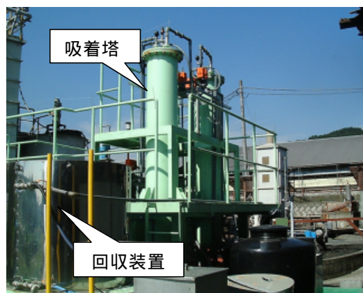
畜舎排水用リン除去装置
