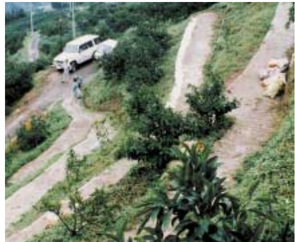
写真9 第4期工事区の園内作業道
