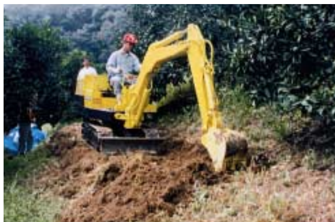
写真7 小形バックホーによる掘削・整形
