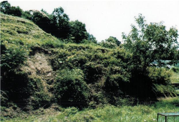
写真8 法面上に灌木などの障害物が存在すると、放牧牛はそれを回避するため法面を登降する。そうした場所では比較的大きな法面崩壊が発生した。
