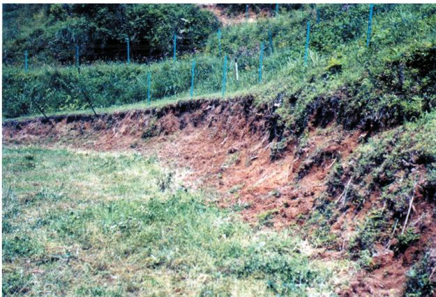
写真14 畦畔法面の上縁部に設置された牧柵が原因で著しく裸地化された法面。
