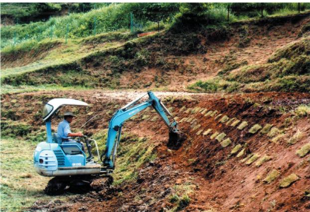
写真10 人工牛道の造成。法面の上端から約120cm下方に段差を設けた。裸地部分には「生牛糞を用いた張りシバ法」を適用した。
