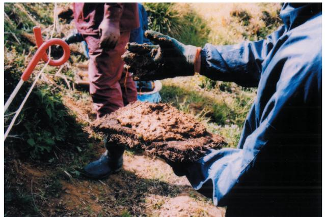
写真15 生牛糞の混合物をシバ苗の裏面に塗布し，修復部分に圧着した。
