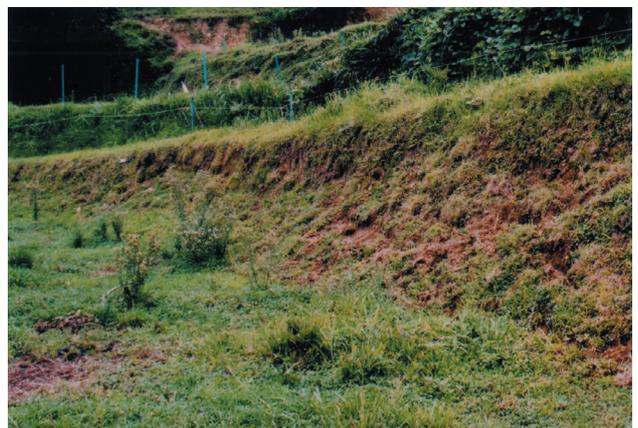
写真17 修復部分を電気牧柵で囲い，約1年間養生すると，放牧の再開が可能であった。
