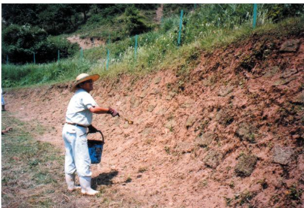
写真16 シバ苗の張り付け作業。生牛糞の持つ接着作用により，苗は竹串などで固定しなくても脱落することはなかった。
