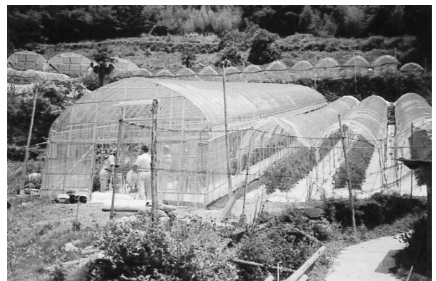
写真7 傾斜方向に建てた鉄骨補強型パイプハウス
