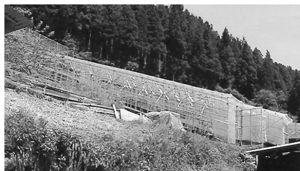
写真15 施工手順の確認を行った平張型傾斜ハウス
