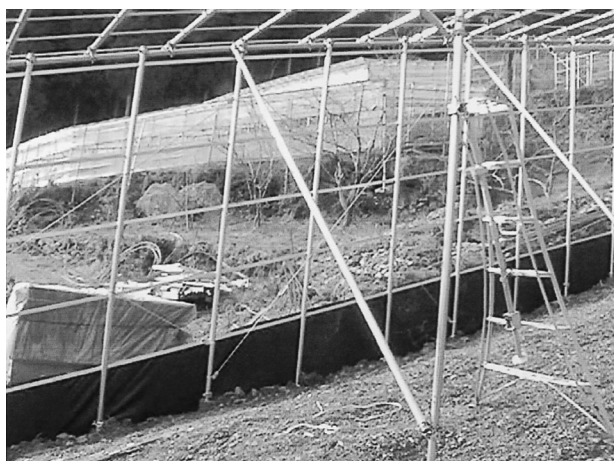
写真13 プレースおよび筋交い補強
