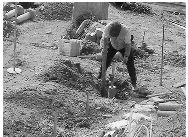
写真11 主基礎の埋設作業
