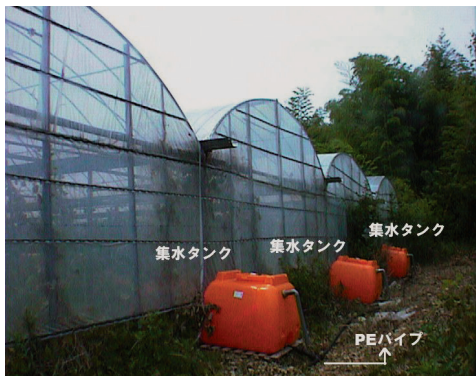
写真4 ハウス下の集水用タンク
