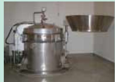
解剖室 と体滅菌装置投入口
