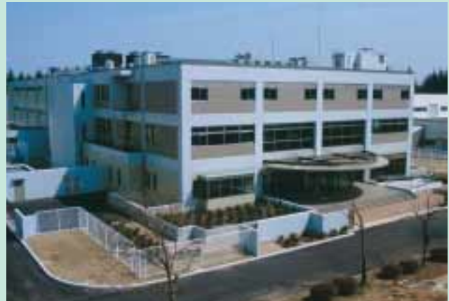
平成16年4月吉日 竣工式を迎えた動物衛生高度研究施設
