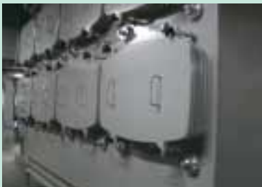
2階機械室へパフィルター
