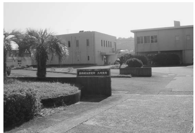
写真2 九州支所昆虫媒介性ウイルス実験棟
