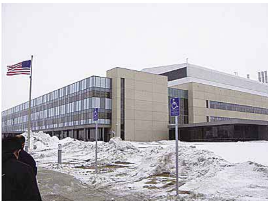
写真1 National Center for Animal Health (NCAH) 本庁舎外観。 右手前の黒いガラス部分がエントランスとなっている。
