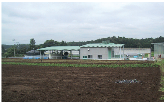
写真1 山田バイオマスプラント全景
