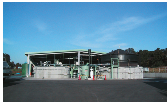
写真2 メタン発酵プラント
