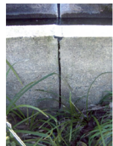
図3 施工後の止水状況
