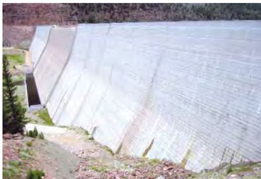
写真1 Upper Stillwaterダム (H=88m、1986竣工)
