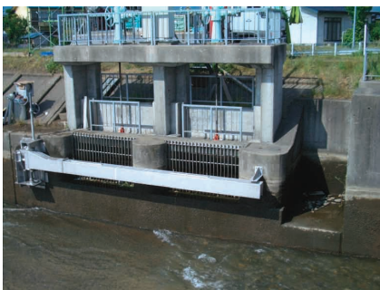
図2 浮遊性ゴミ流入防止装置（洪水時）
