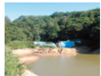
写真 下流側から見た被災直後の平田池（上池）
