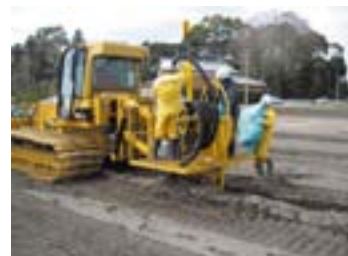
写真1 開削型暗渠形成装置「ベスト・ドレイン」
