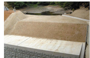
写真3 平田ため池における越流許容型ため池工法の適用状況 (左：土嚢設置状況、右：ソイルセメントによる覆土処理後)
