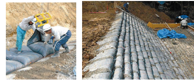
写真2 施工中の状況
