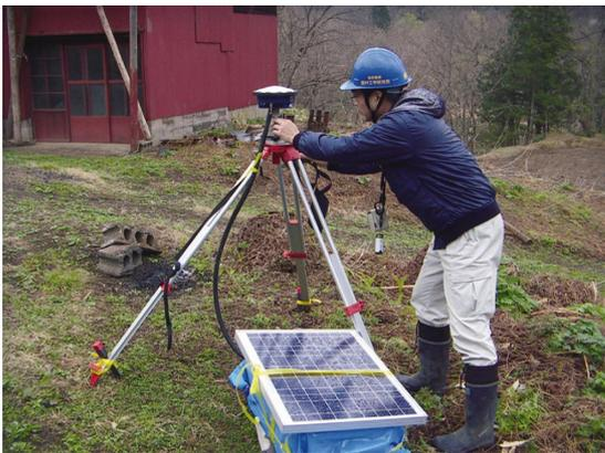
写真 GPSを利用して地表の動きを観測する機器の設置状況(4月22日、七五三掛地すべり地区)
