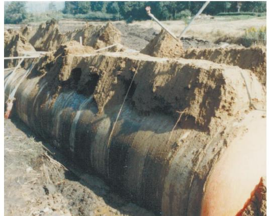
写真1 大口径パイプの降雨による浮上事例
