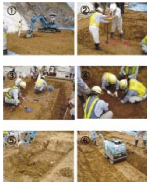
図2 ワイヤレス埋設計器の設置手順
