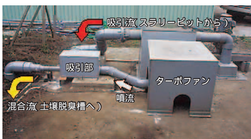
写真1 酪農家に設置した空気エゼクタ
