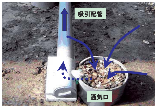
図2. 目詰まりを防止する通気口と吸引配管
