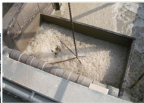
▲養豚農家における実証試験の様子1 既設設備の改造により構築した結晶化装置
