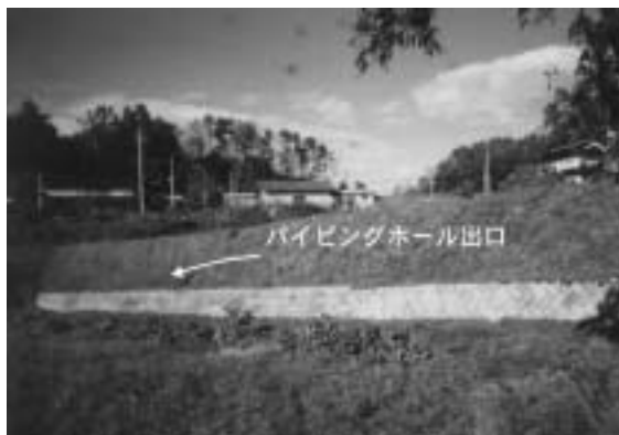
Photo 3-16 柳ため池下流 Yanagi dam
